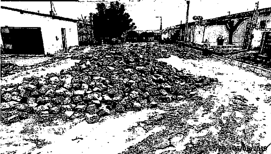
BM 04 - Contrato de Repasse 834700/2016 Ministério do Cidades - Implantação de Pavimentação em Vias Públicas Urbanas - Cajazeiras/PB (Rua João Bernardo de Oliveira - Meio-Fio)
