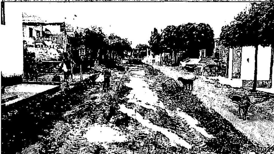
BM 04 - Contrato de Repasse 834700/2016 Ministério do Cidades - Implantação de Pavimentação em Vias Públicas Urbanas - Cajazeiras/PB (Rua João Bernardo de Oliveira - Regularização + Nivelamento)
