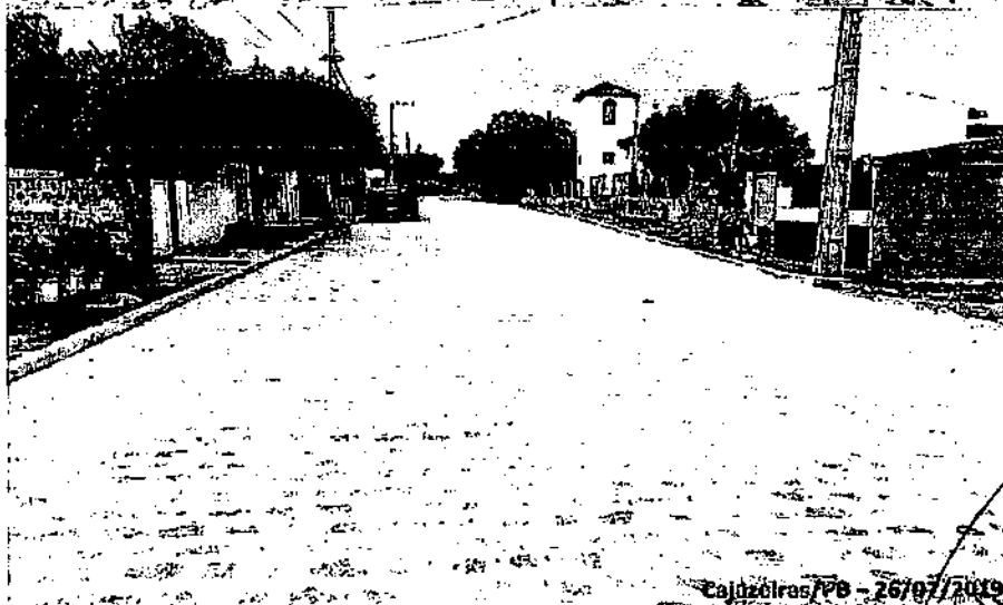
BM 04 - Contrato de Repasse 834700/2016 Ministério do Cidades - Implantação de Pavimentação em Vias Públicas Urbanas - Cajazeiras/PB (Rua João Bernardo de Oliveira - Pavimentação)
