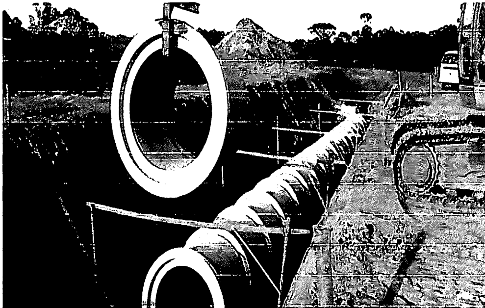
Figura 5 - Exemplo de modelo de tubulação para drenagem
