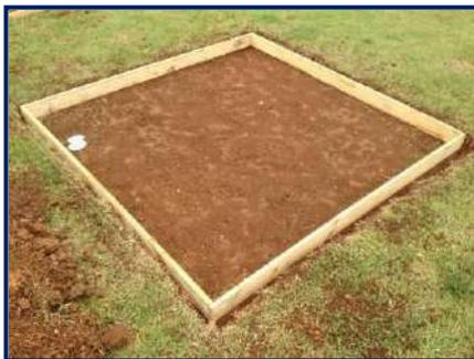
2. Perfure o centro da área demarcada em 30 cm de diâmetro e 60 cm de profundidade e insira a Cadeira de Fundação mantendo as pontas roscadas 2,50 cm acima da base.
