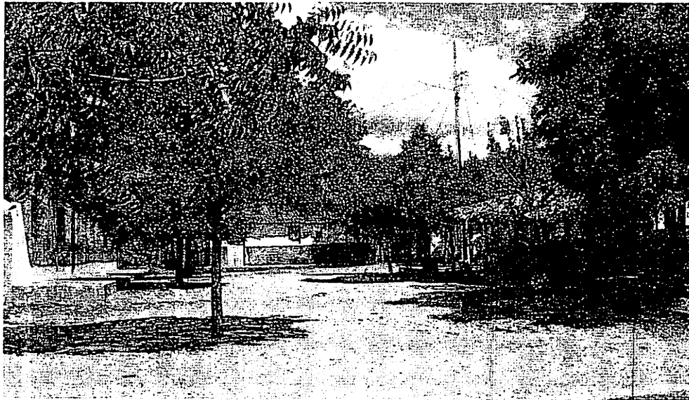
RUA PROJETADA 02 (PIRANHAS VELHA)
